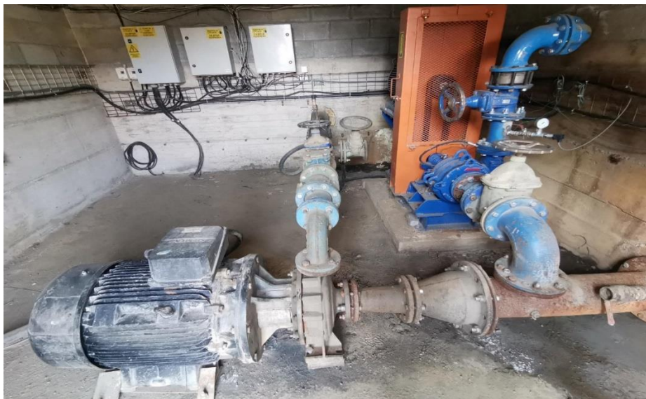
Слика 5 Пумпна станица за систем на прскалки за отпрашување на Х.Ј 4
