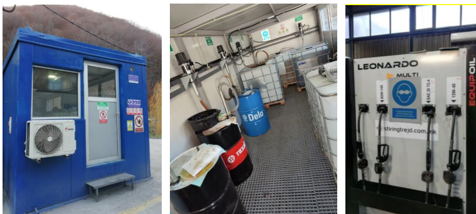
Слика 2 Станица за преточување на масти и масла во склоп на работилница за сервисирање Епирок
